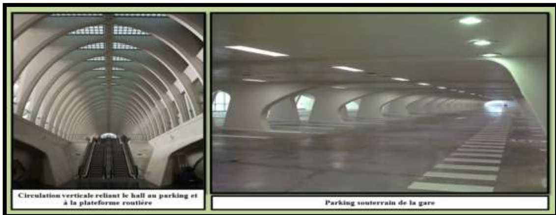
Photo 7: Vues depuis parking souterrain et circulation verticale reliant le hall au parking et à la plateforme routière de la gare
