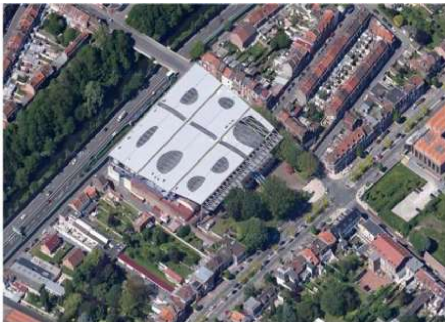
Figure 14 : Vue aérienne sur le site du Fresnoy. Source : Google Image.
