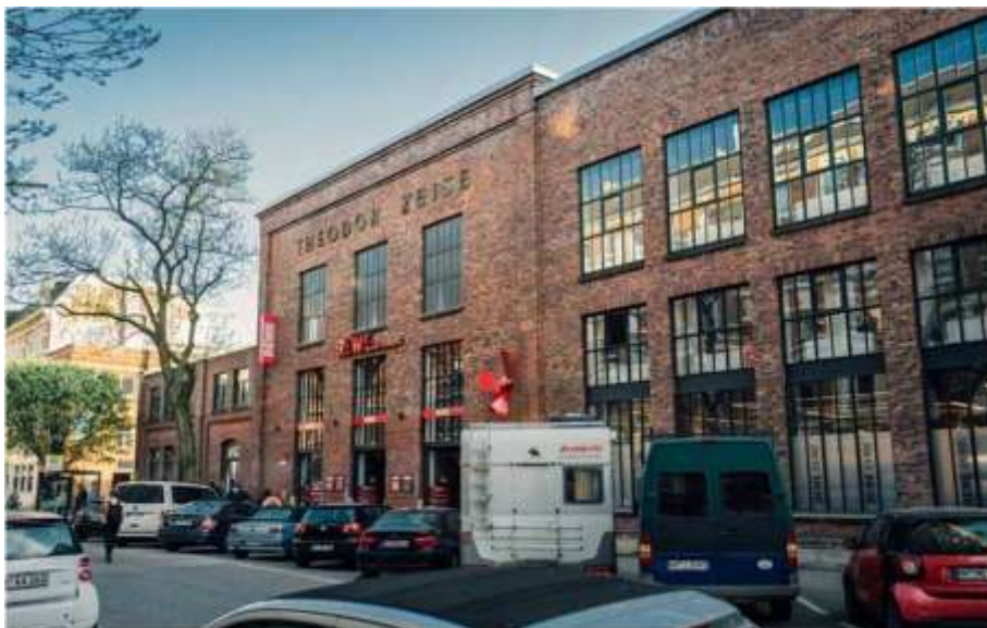
Figure 23 : Façade principale du Zeise Hallen . Source : Google Image
