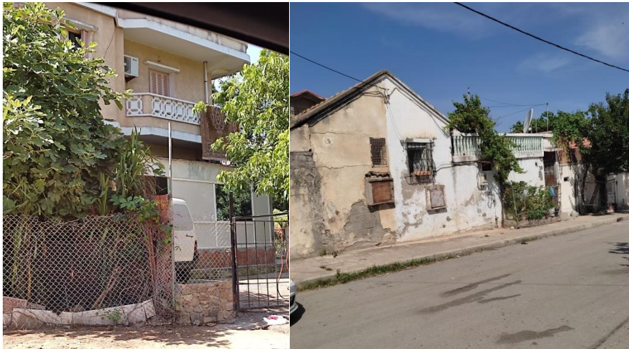
Figure III 8: Habitat individuel Habitat type arabe Source : des photos present par auteurs 04 /2021
