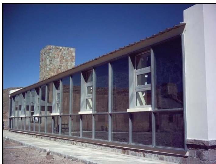
Figure III.8 : Vue sur la façade nord. Source : (Hernández et al., 2009).
