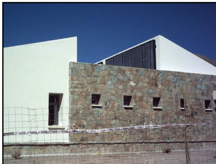
Figure III.11 : Vue de la façade ouest montrant une section de double murette en quartzite local. Source : (Hernández et al., 2009)
