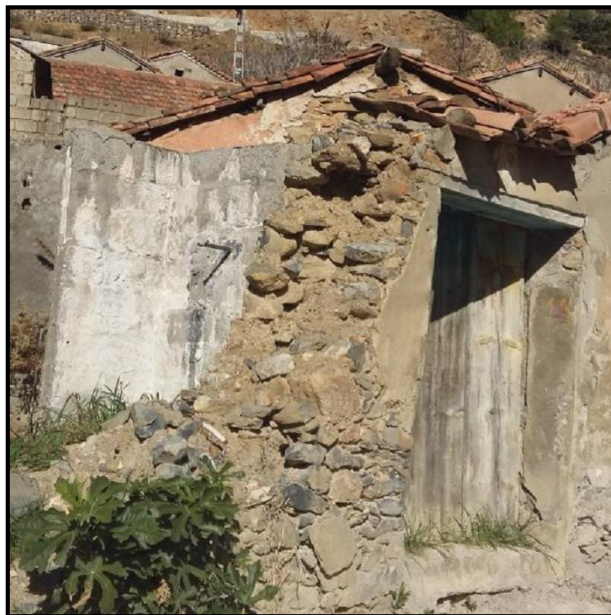
Figure II.1 : Mur en pierre. (Source : Messaoudi, 2017).
