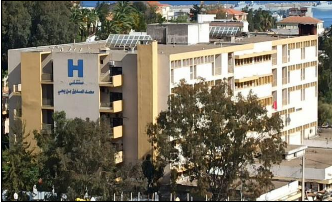
Figure III.13 : Vue sur le côté sud du bloc de l'hospitalisation.
