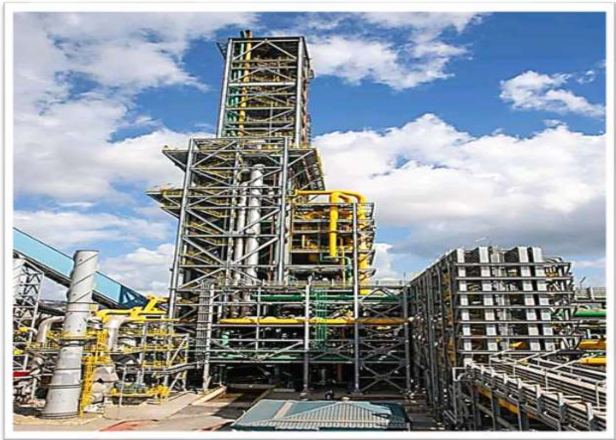
Figure I.2 : Unité de production de l'acier (DRI).
