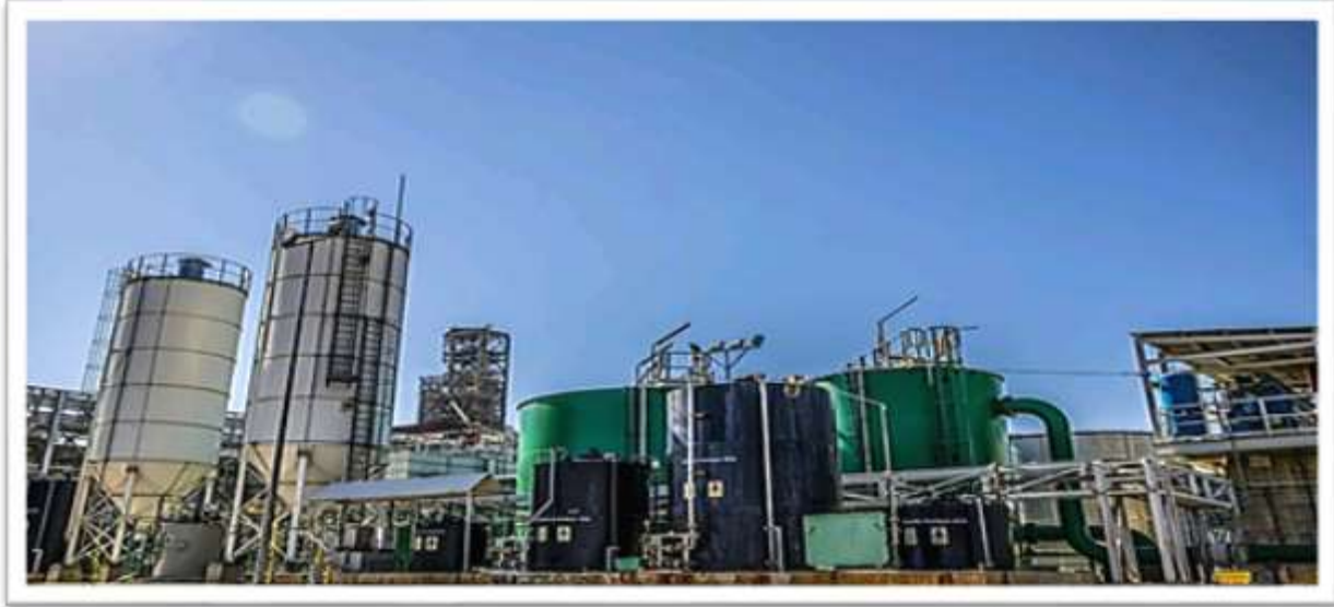
Figure I.8 : Station générale de traitement des eaux (WTPg).
