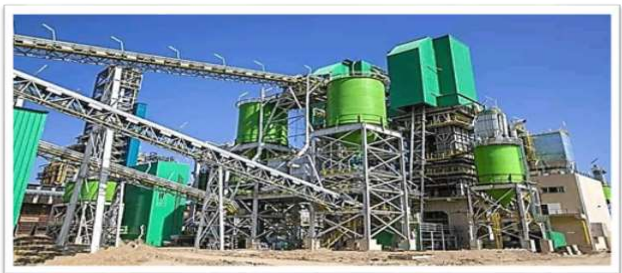
Figure I.6 : Unité traitement de chaux (Lime plant) (LMP).
