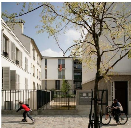
Figure 36: Cheminements et cour Dagorno, Paris 20e, Philippe Prost architecte
