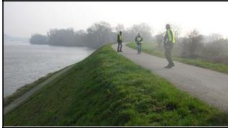
Figure 33 : Digue de protection contre les inondations ou submersions
