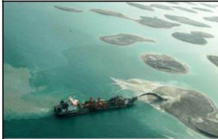
Figure 56 : la technique de réalisation de remblai à l'aide des bateaux
