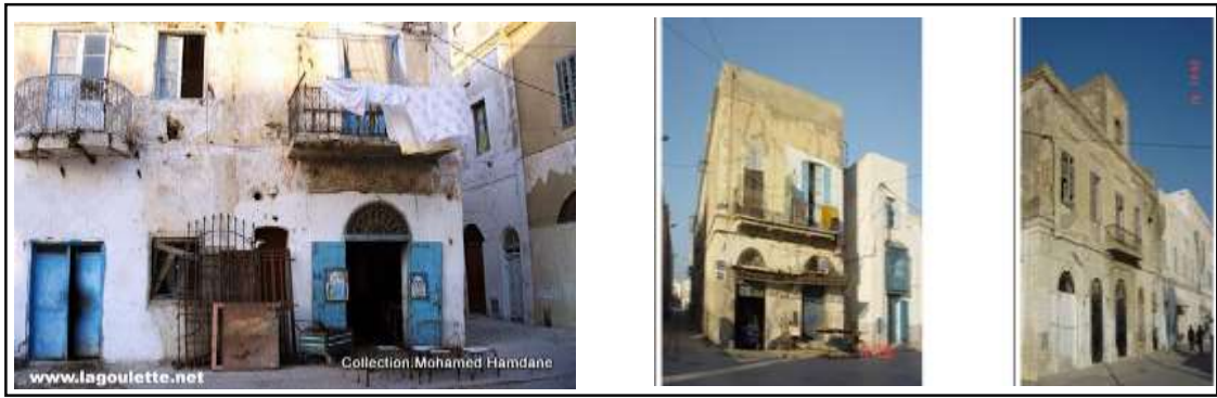
Figure 10 : Des bâtiments vétustes d quartier de la petite Sicile.
