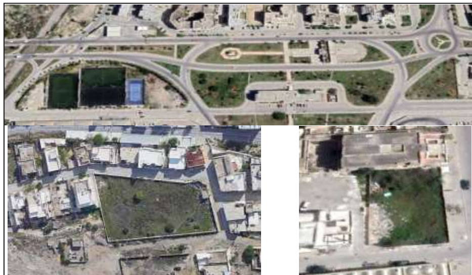
Figure 13 : L'état des espaces verts avant la rénovation du quartier.
