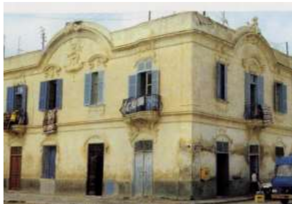
Figure 11 : Bâtiment du quartier avant la réhabilitation.
