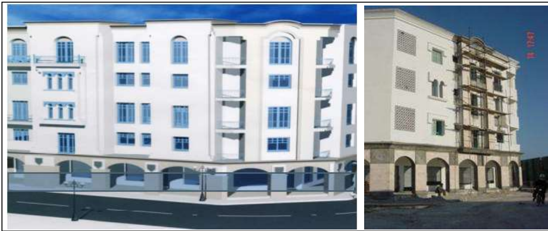
Figure 12 : La façade des bâtiments de quartier avant et après la réhabilitation.
