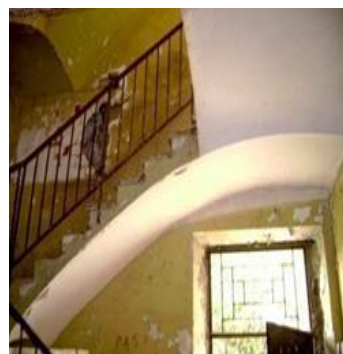
Figure 66: escalier à l'intérieur de la villa Andreu Source: personnelle
