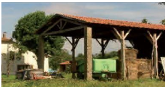
Figure 17: Un hangar à RontalonSour e: Paysages et bâtiments agricoles: Guide à l'usage des agriculteurs. "Conseil d'architecture d'urbanisme et de l'environnement de RHON"
