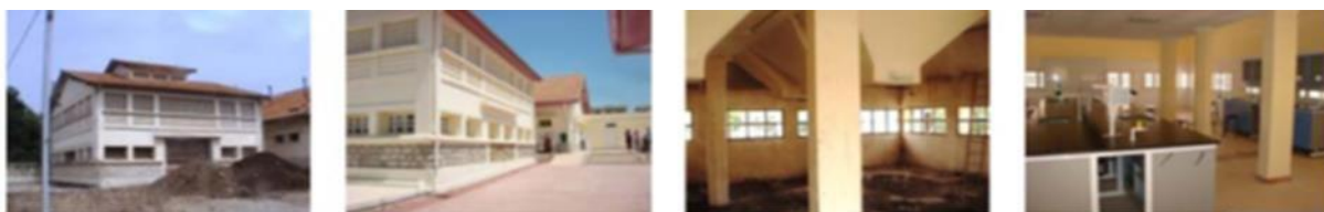
Figure 38: ferme coloniale réhabilitée en structure pédagogique
