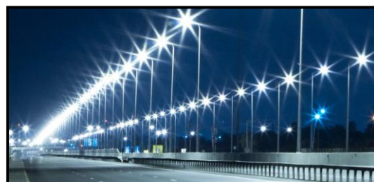
Figure 114 : Système de gestion intelligente de l'éclairage public. Source : https://circutor.com .
