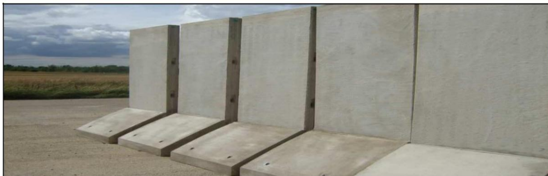
Figure II.13: Mur en béton armé.
