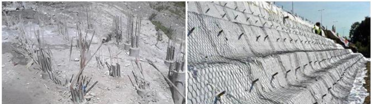
Figure II.11: Clous et micropieux.
