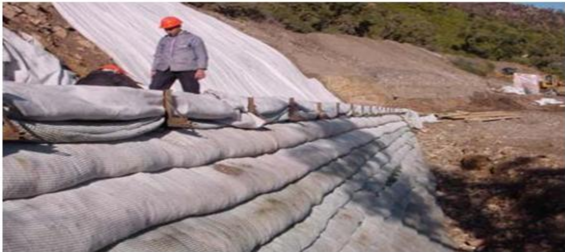
Figure II.14: parement préfabriqué devant le massif en géotextile.
