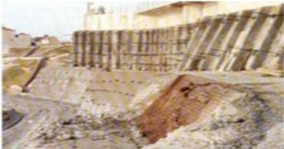
Figure. I.24 : Des écrans de soutènement fixés par des Tirants d'ancrage.
