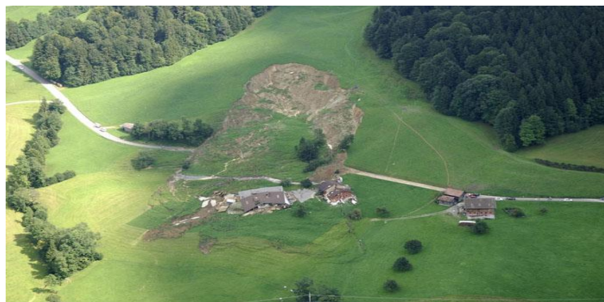
Figure. I.1 : Glissement de terrain profond Allemagne source [1].
