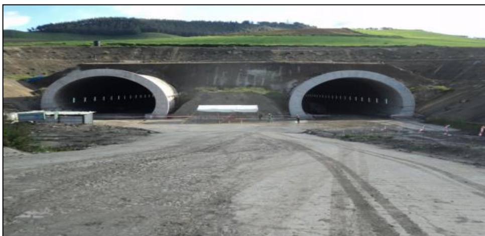
Figure IV.1. Portails sud de tunnels T4 (photo sur site).
