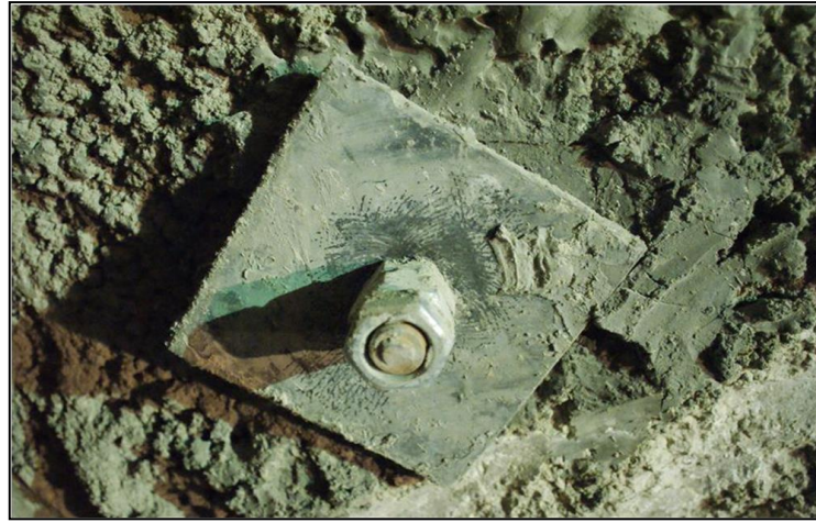
Figure IV.10 : Boulon d'ancrage avec une plaque en acier (Tunnel T4).
