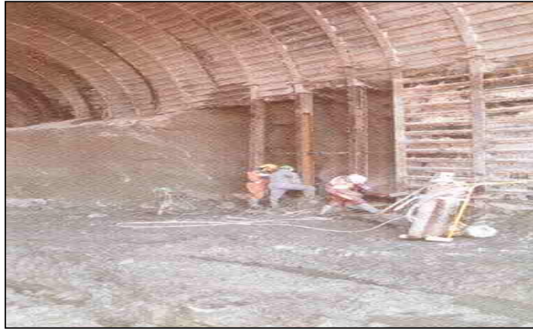
Figure III.1 Soutènement par blindage
