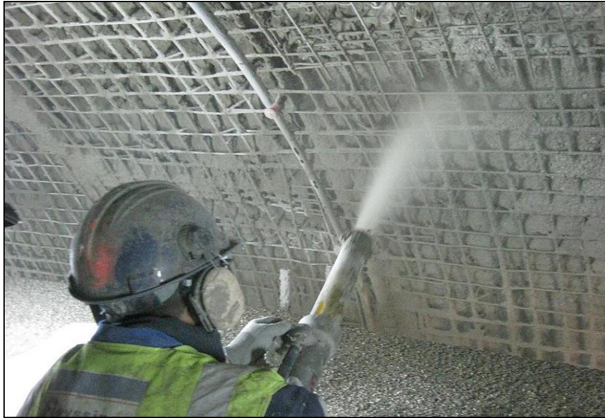
Figure IV.11 : Béton projeté (Tunnel T4).
