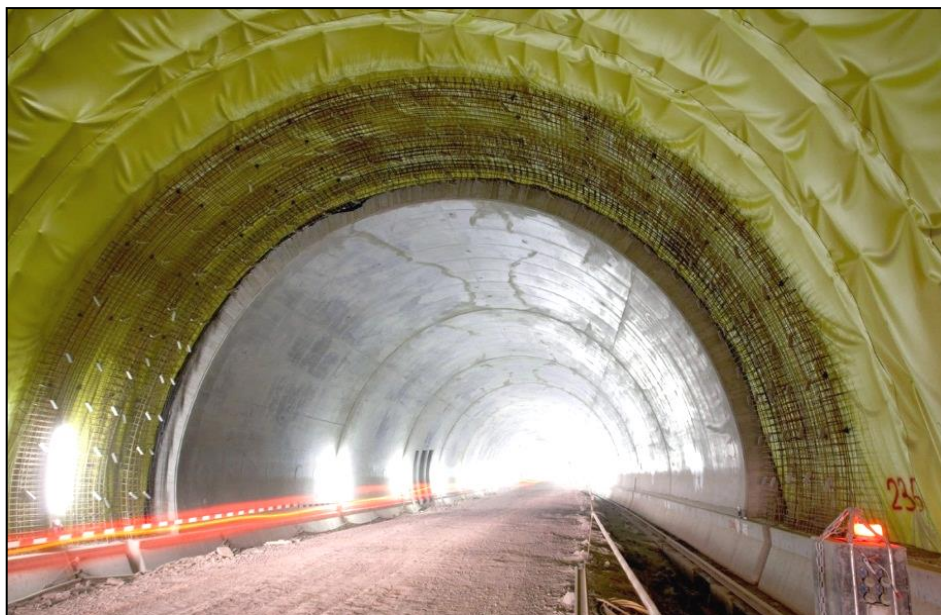
FigureIV.13 : Etanchéité du tunnel T4.
