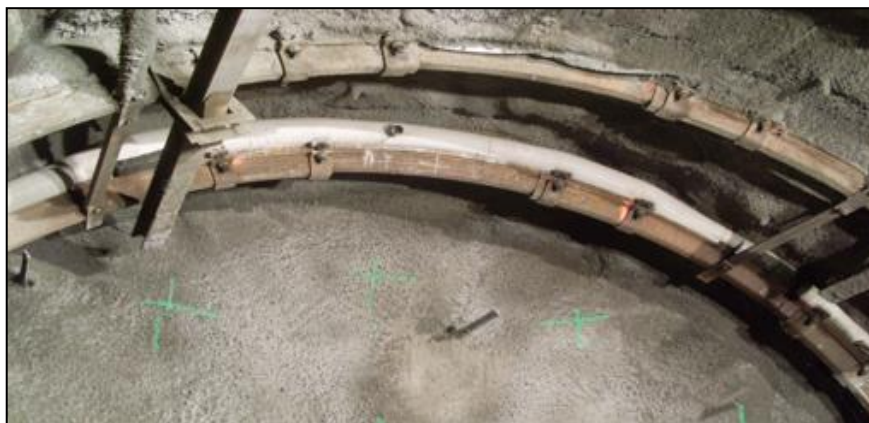
Figure III.4 : Cintres TH Détail dans la voûte d'une galerie
