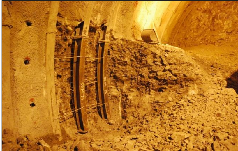
FigureIV.9 : Cintres HEB –Tunnel T4
