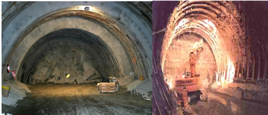
Figure II.9 : creusement à pleine section
