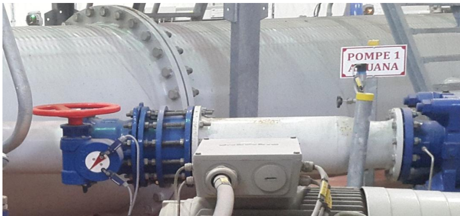
Figure (I.14) : Organes et accessoires de la conduite d'aspiration.
