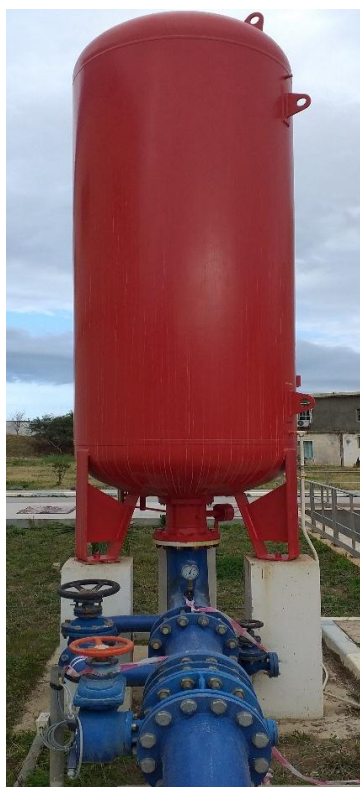
Figure (I.17) : Réservoirs anti béliet à vessie.
