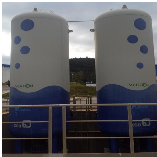
Figure (I.16) : Réservoirs anti béliet classique.
