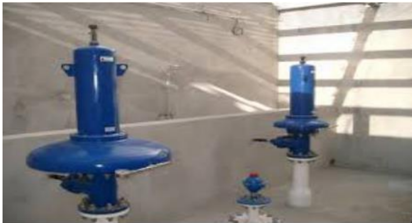
Figure (VI-7) : Une Soupape de décharge.
