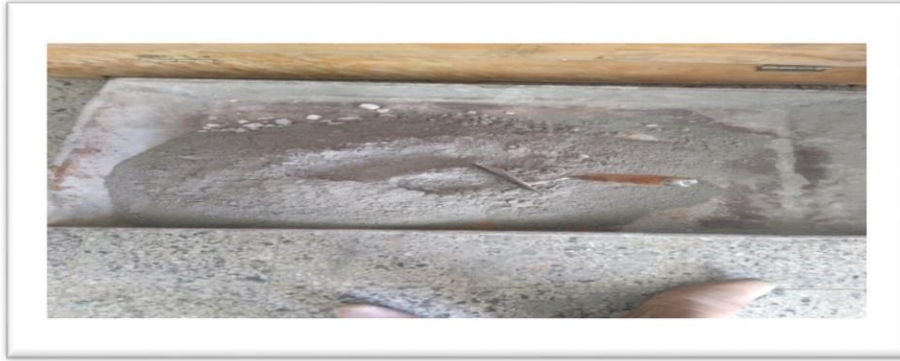
Figure13 /CH2 : Malaxage du béton
