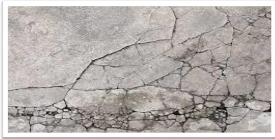
Figure 5/CH1: le problème de retrait dans le BHP
