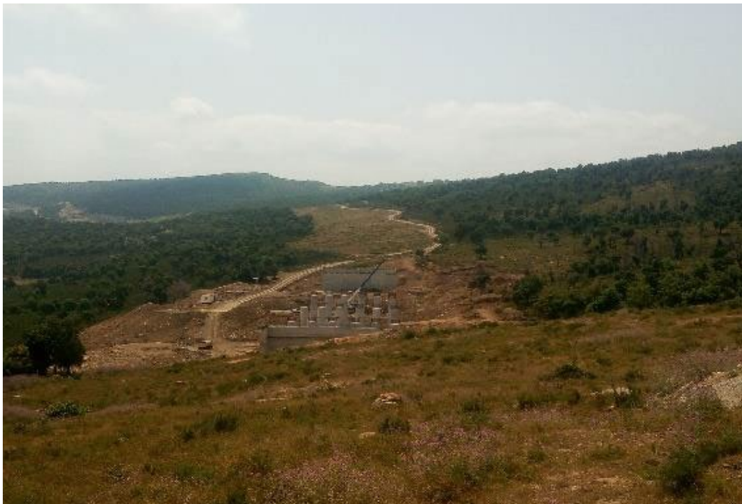
Figure XI.10 : Travaux de chantier au niveau de la forêt Oulben.
