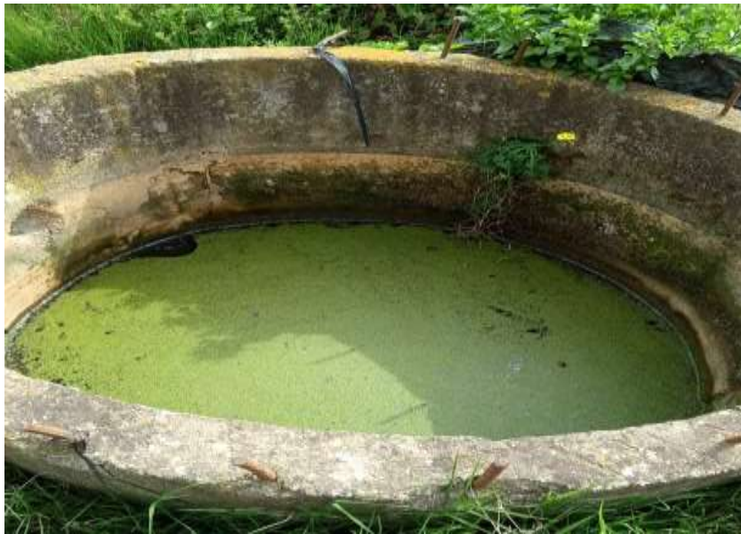
Photo .10 : Problème d'eutrophisation provoqué par l'Ammonium
