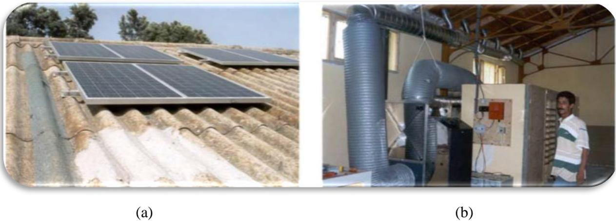
**Figure 08 :** Photographie des sources d'énergie d'un séchoir hybride ; (a) : Cellules photovoltaïques ; (b) : Source d'énergie d'appoint (gasoil) (Ouaouich et Chimi, 2005).
