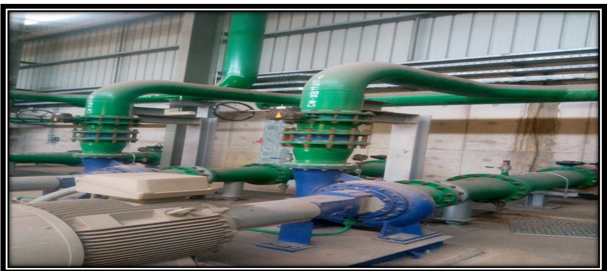
Fig.29. Le circuit CW de l'unité XB11
