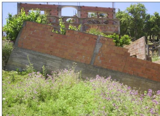
*Fig.V.10. Désordres enregistrés aux niveaux des Constructions.*
