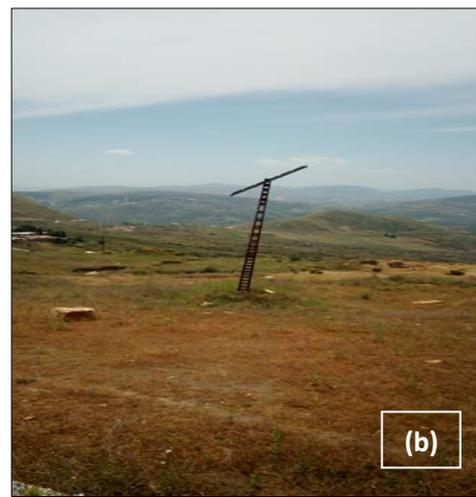
**Fig.V.3.** Photos illustrant :<sup>(a)</sup> l'inclinaison des arbres ;<sup>(b)</sup> l'inclinaison des poteaux électriques.
