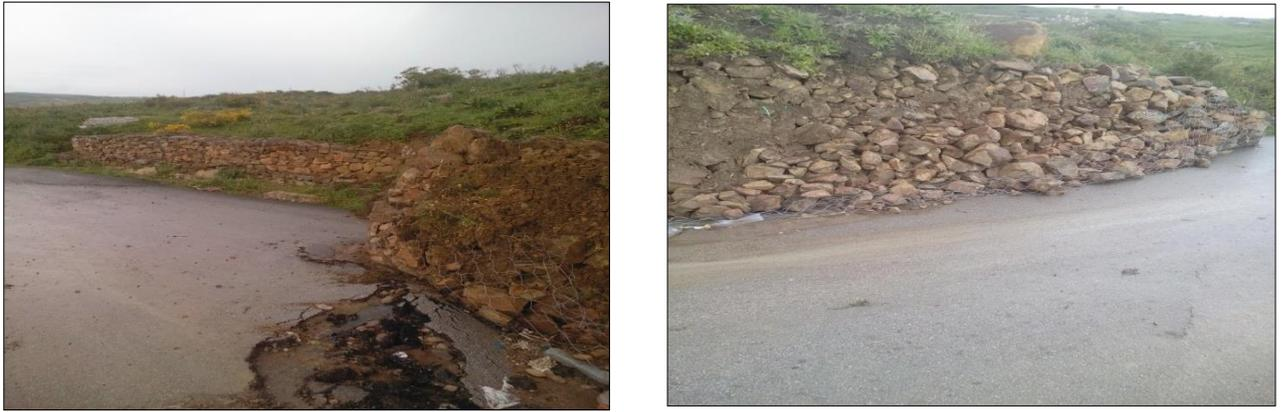
**Fig.V.4.** Photo illustre le gabionnage endommagé.
