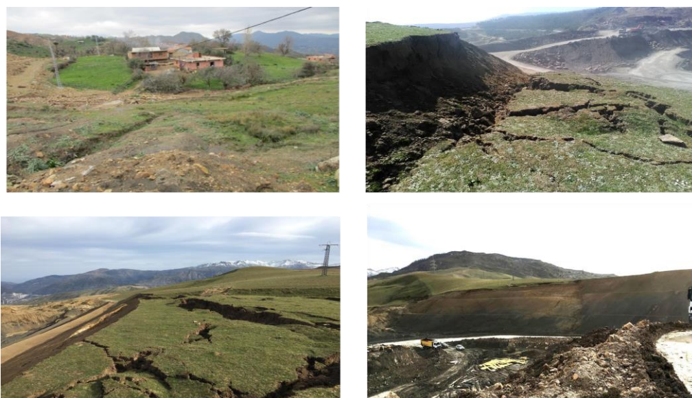
Fig.V.1. Dégradations observées au niveau du site d'étude.
