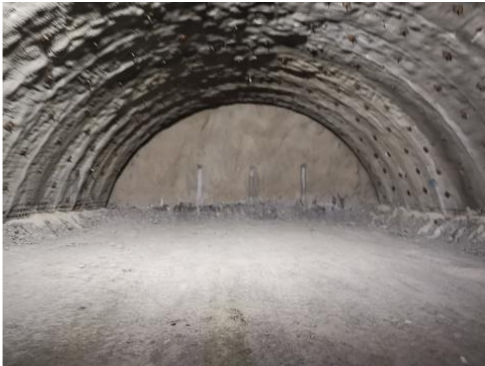
Fig. IV.3. Béton projeté renforcé par les boulons utilisé au niveau du tunnel
