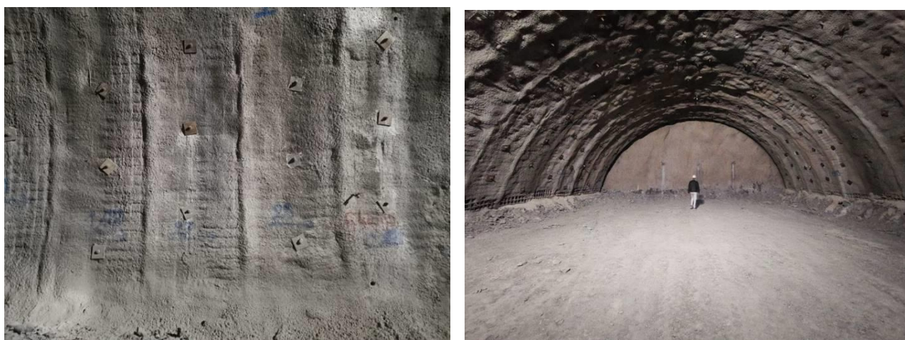
Fig.I.6. Soutènement par béton projeté et boulonnage au niveau du tunnel de Texenna
