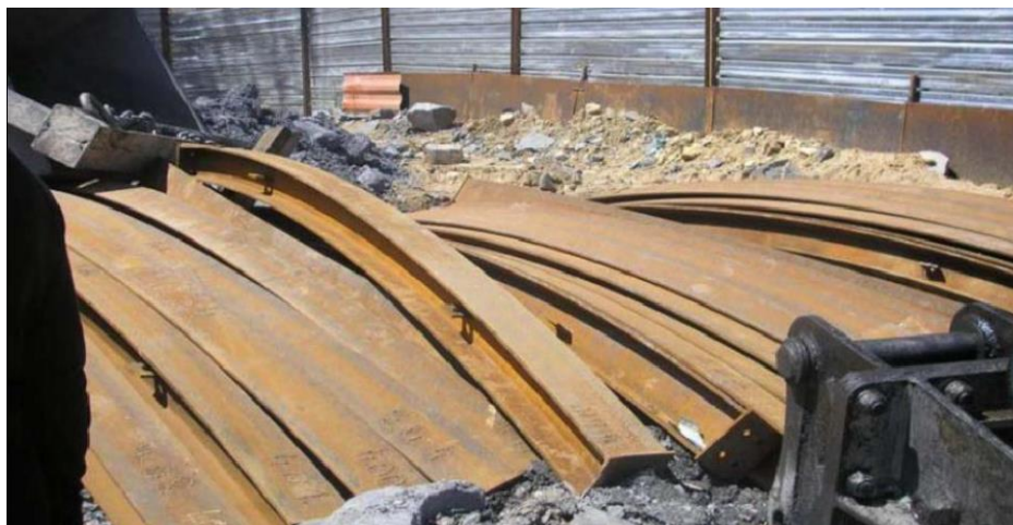
Fig. I.5. Cintres métalliques (Gherda, 2020)
