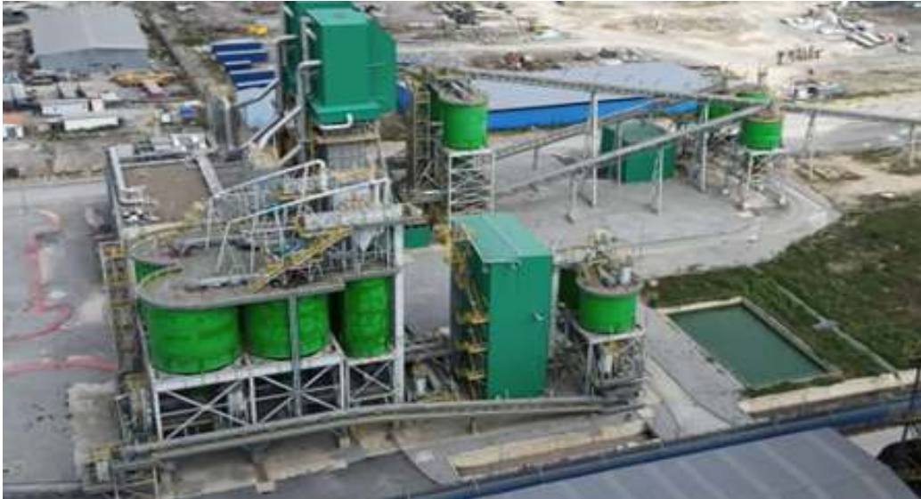
Figure I-5. Unité de production de chaux.
