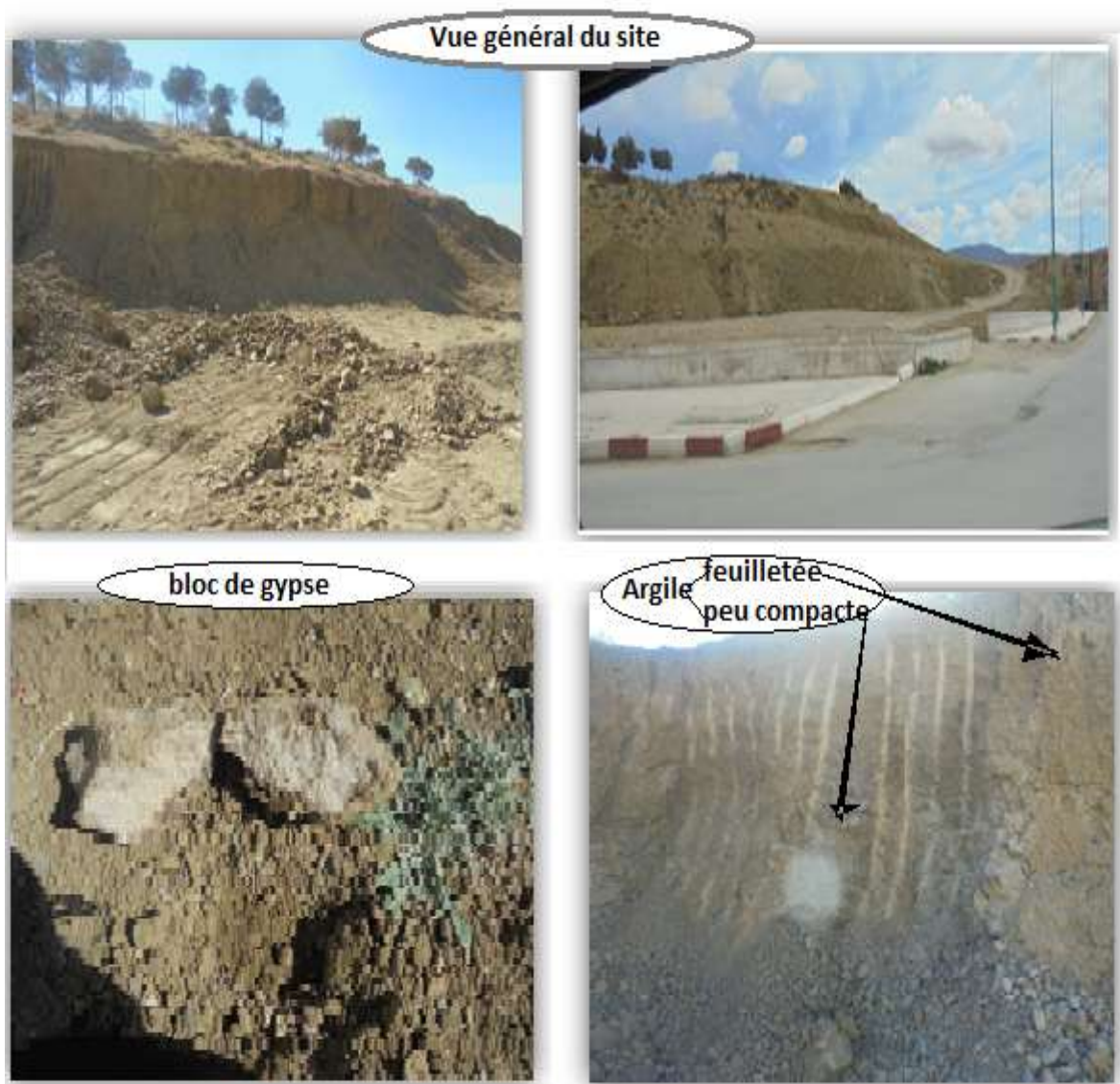
Figure 73: Photos prise sur site.
