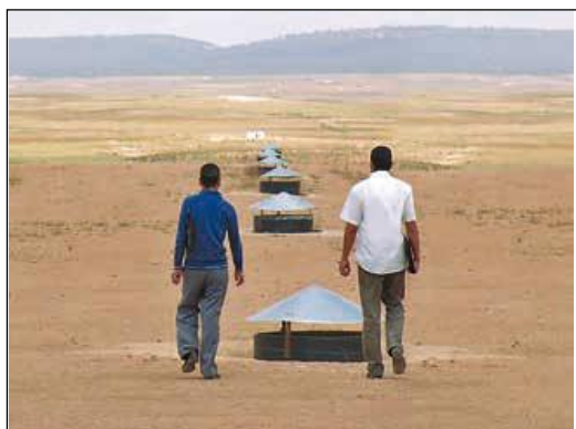
Décharges en cours de réhabilitation à Djelfa
