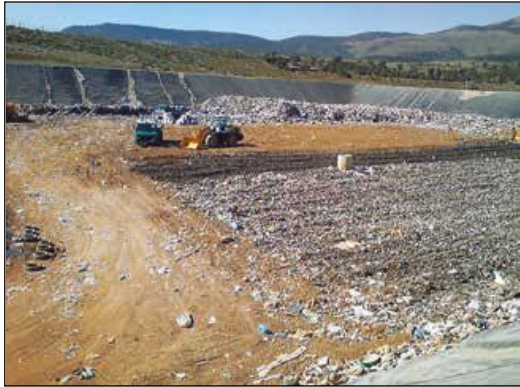
CET en exploitation à Tébessa
