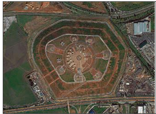
Décharges en cours de réhabilitation à Oued Smar (Alger)
