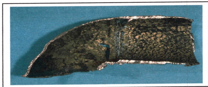
Figure (I.3) : Corrosion par érosion d'un tube en cuivre véhiculant de l'eau [10].
