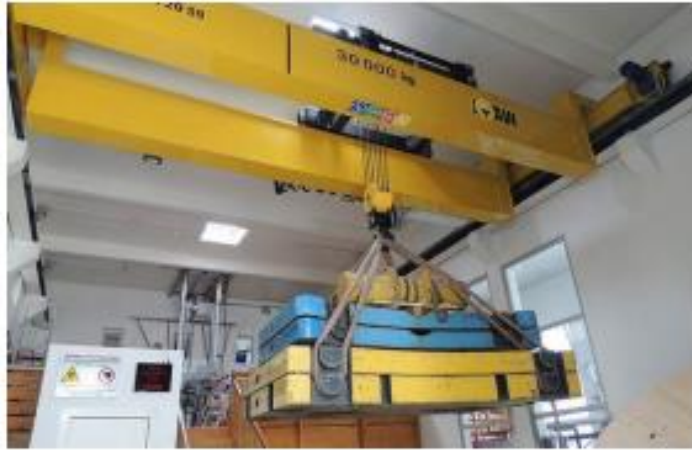
Figure I.4: Un pont roulant posé.
