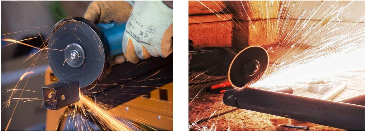
**Figure III. 5 : Coupage des tubes carrés.**
