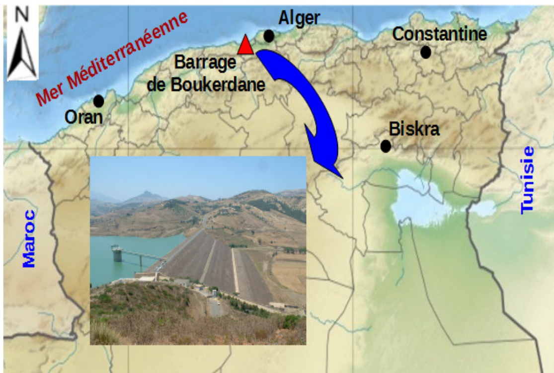
Figure III.1 : Localisation du barrage de Boukerdane.
