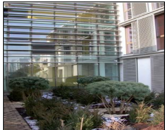
Figure 21 : Vue sur le patio entre la mairie d'origine et la partie administrative (Source : Ekopolis, 2010).
