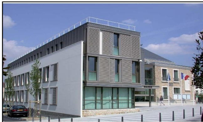
Figure 19 : Vue sur les différentes façades : en béton peint et persiennes métalliques, en bardage métallique et la mairie d'origine rénovée. Au milieu de la façade sud se trouve l'entrée principale (Source : Ekopolis, 2010).
