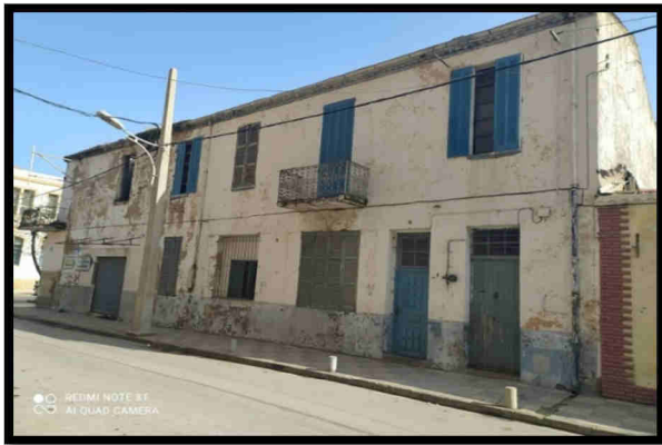
Photo 3.3. Vue sur une Construction en moyen état Source : auteur2021.
