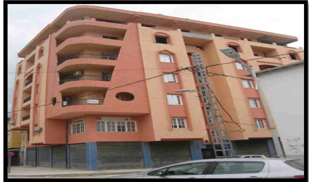
Photo 3.2. Vue sur une Construction en bon état Source : auteur2021
