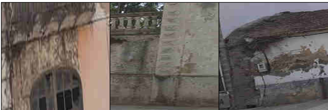
Photo 4.15. Vieillessement et écaillage des enduits de façade sur la réalité Source : auteur2021.
