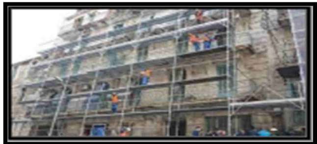
Photo 2.6. Le quartier pendant les travaux de réhabilitation. Source : site internet : tsa-algerie.com
