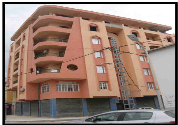
Photo 3.9. Vue sur habitat collectif récent. Source : auteur 2021
