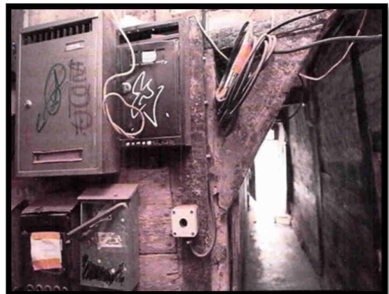
Photo 2.16. Cage d'escalier en états insalubres Source : rennes.maville.com
