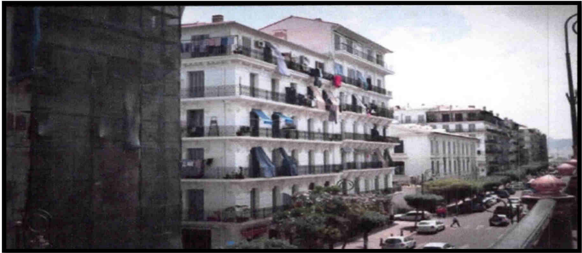
Photo 2.7. Le quartier après les travaux de réhabilitation. Source : site internet : tsa-algerie.com
