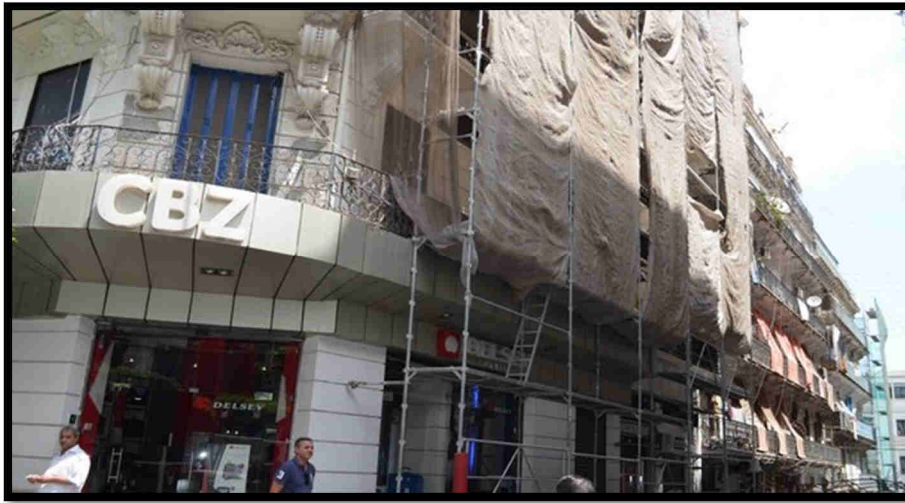
Photo 2.3. Les travaux de réhabilitation au niveau de quartier. Source : site internet : tsa-algerie.com
