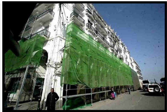
Photo 2.2. Le ravalement des façades. Source : site internet : tsa-algerie.com
