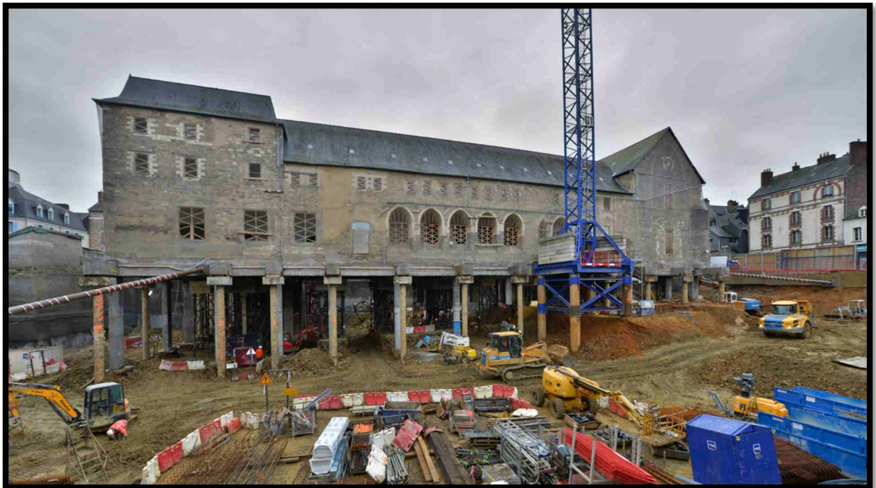
Photo 2.20. Les travaux de réhabilitation de l'équipement le couvent des jacobines.
