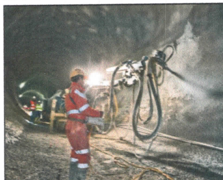
Figure.I.18 : l'emploi de béton projeté.
