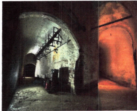
Figure.I.5 : Galerie de stockage.
