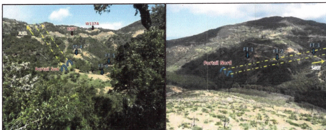
Figure.IV.3: les deux entrées de tunnel.
