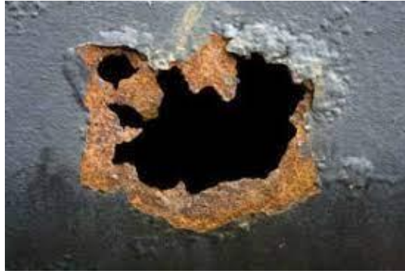
Figure I.19 : Corrosion par piqûre.
