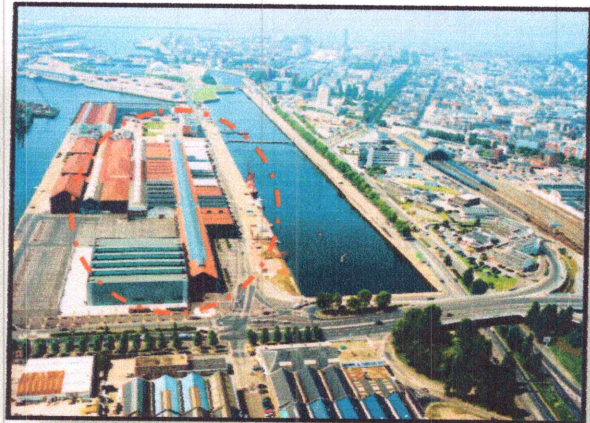
Figure 10 : la réhabilitation des Docks Vauban Source : www.aivp.org
