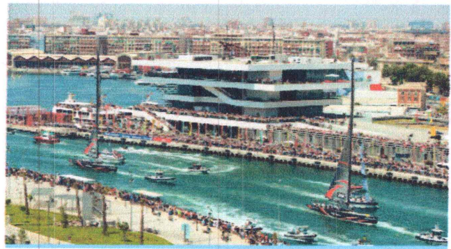
Photo6:le bâtiment «Velas e Vents » signé D.Chipperfield&F.Vazquez. Source : http://www.artvalencia.com .
