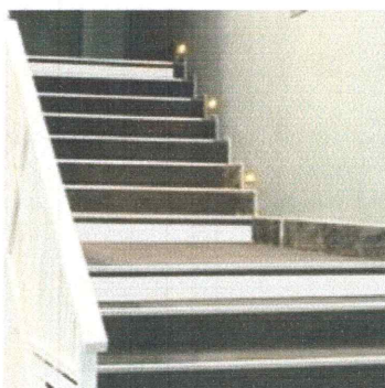
Figure.3.24. Adhésif pour repérage des contremarches
