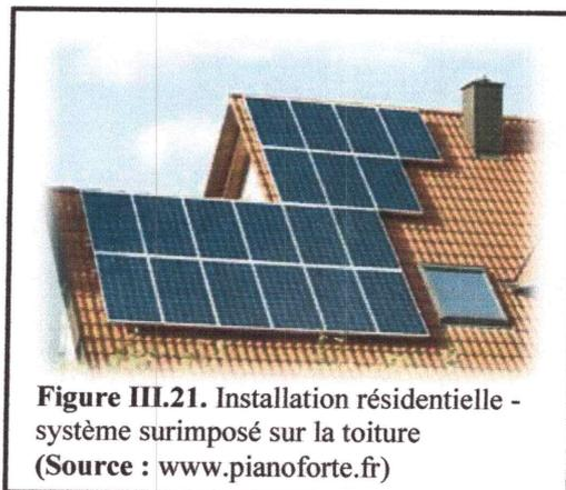
**Figure III.21.** Installation résidentielle - système surimposé sur la toiture
