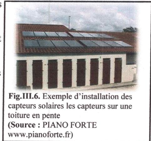
**Fig.III.6.** Exemple d'installation des capteurs solaires les capteurs sur une toiture en pente
