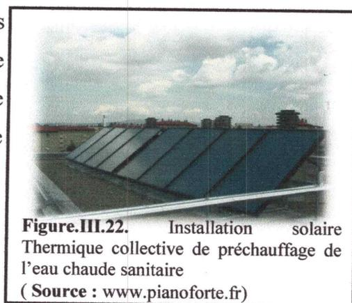
**Figure.III.22.** Installation solaire Thermique collective de préchauffage de l'eau chaude sanitaire
