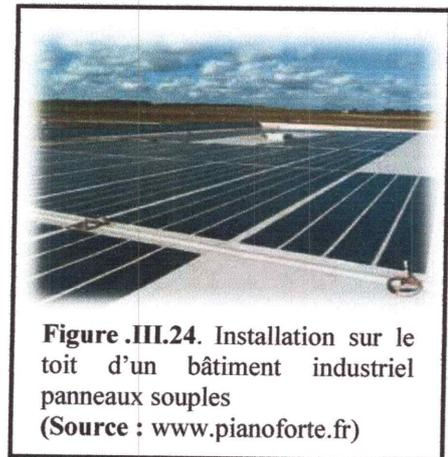
**Figure .III.24.** Installation sur le toit d'un bâtiment industriel panneaux souples
