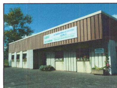
Figure-I- 24 : Établissement et service d'aide par le travail « Les Laudières » à Vineuil
