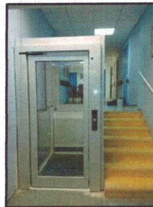
Figure III-85 : Appareil élévateur vertical desserte de niveaux allant jusqu'à 1.20m
