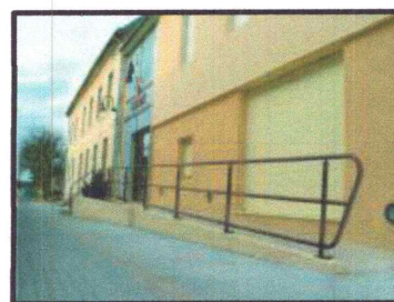
Figure III-72 : Rampe d'accès d'un immeuble
