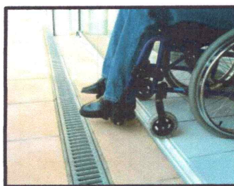
Figure III-68 : Fentes parallèles au sens de la roue du fauteuil roulant
