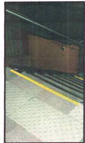
Figure III-82 : Une bande de matériaux d'aspect marquant le changement de niveau
