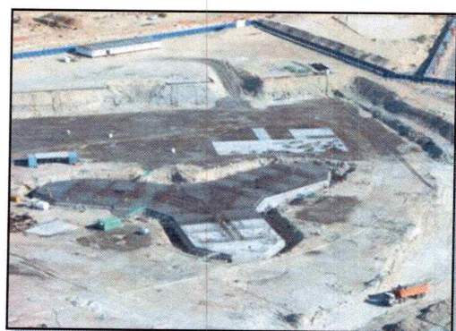
Photo 16 : Fondations de la tour Burdj Dubaï Source en ligne : http://fr.wikipedia.org/wiki/Projets_de_gratte-ciel
