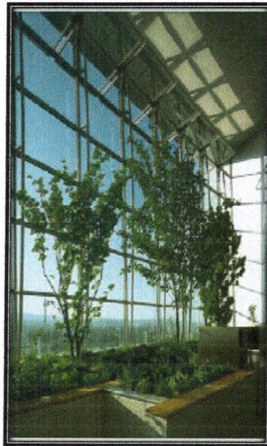
Photo 9: Un canal accessible dépassé 200cm (grand atrium)
