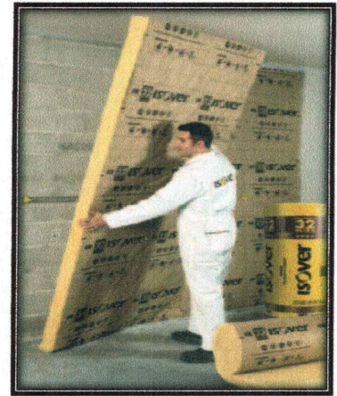
Photo 4 : Mise en œuvre d'un Isolant Par l'intérieur
