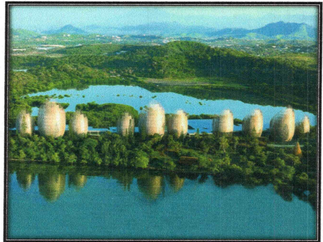
Photo 30: Vue générale sur le site de
