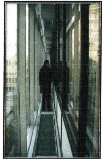
Photo 10: Un canal accessible de 200cm
