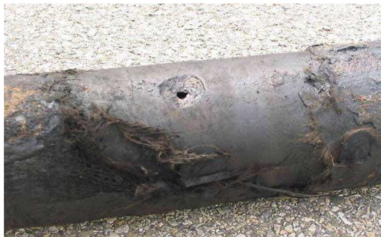
Figure (I, 4) : Corrosion par caverneuse. [3]
