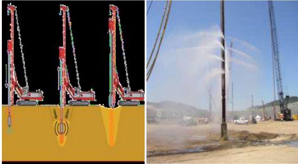
Figure I.13 : Renforcement Par amélioration dans la masse.
