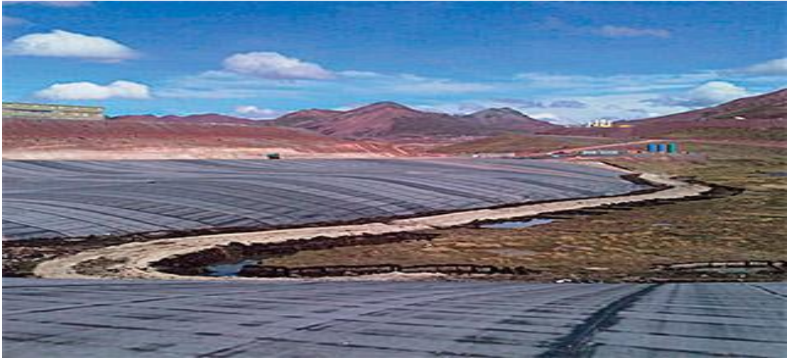
Figure I.7 : Une géo-membrane bitumineuse.
