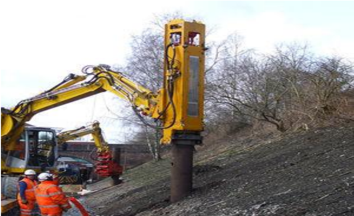
Figure II.8. : Marteaux de battage.
