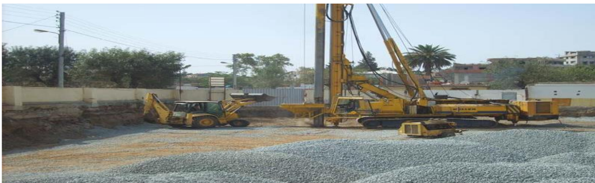
Figure I.15 : Exemple de vibreur Keller (Voie sèche, site : mosquée de Boudouaou)
