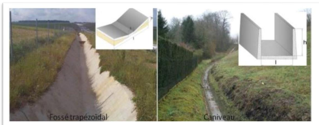
Fig. III-8. Exemple Drainage de surface
