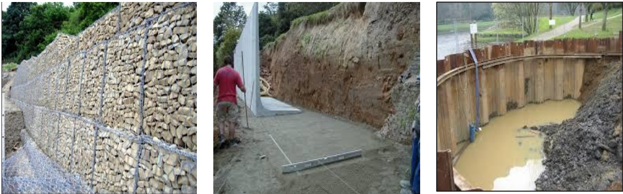
Fig. III-13. Différents types des ouvrages de soutènements
