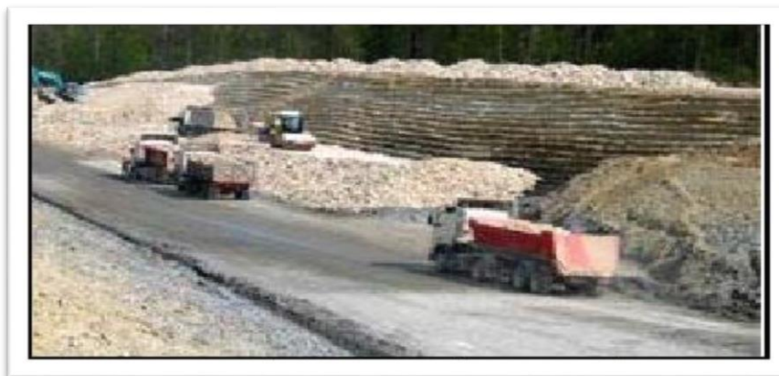
Fig. III-10. Réalisation d'un masque drainante
