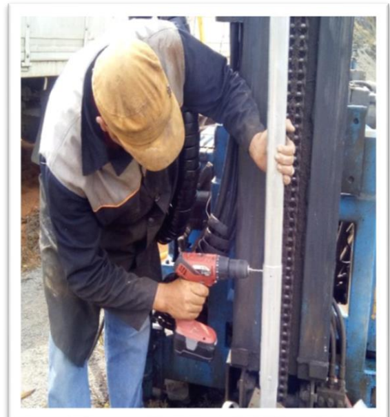
Fig. IV-17. Exécution d'un piézomètre et inclinomètre à l'aide d'une sondeuse APAFOR
