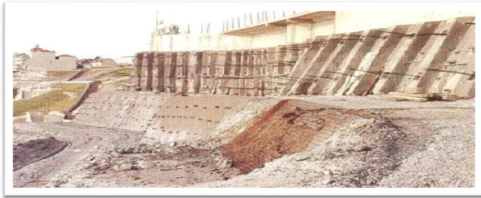
Fig. III-14. Exemple de tirants d'ancrage actif
