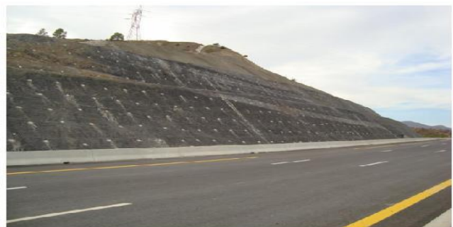
Fig. III-15. Stabilisation par Clouage
