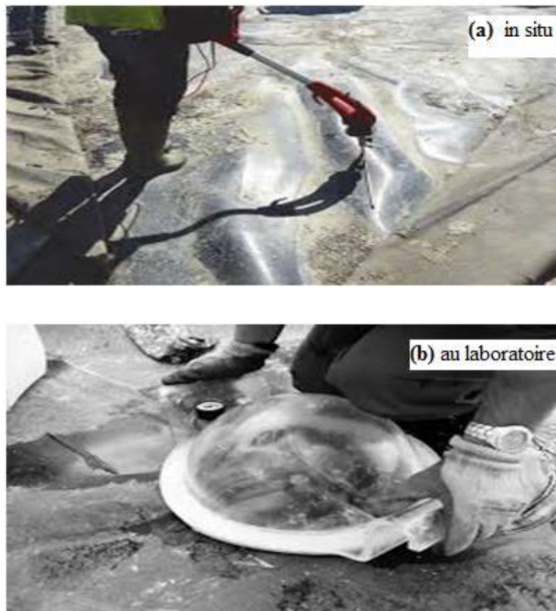
Figure II.26 : Contrôle des géosynthétiques
