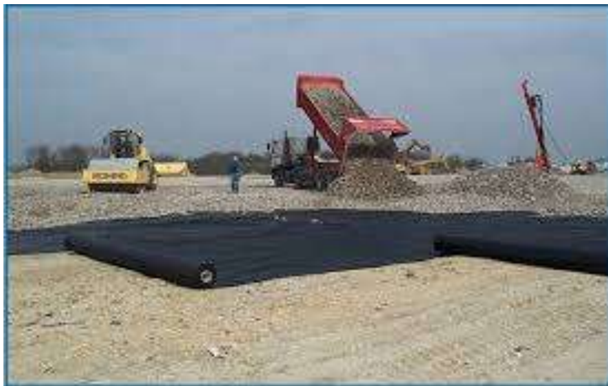
Figure II.25 : Recouvrement des géosynthétiques par le sol.
