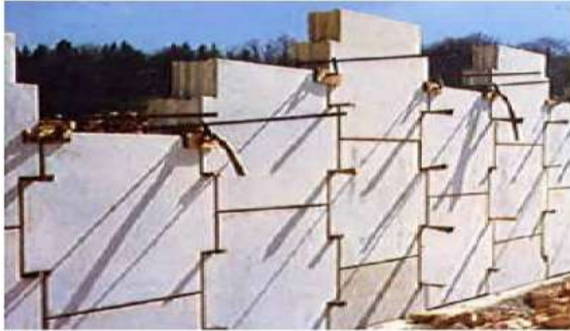
Figure I.15: Montage d'un parement.
