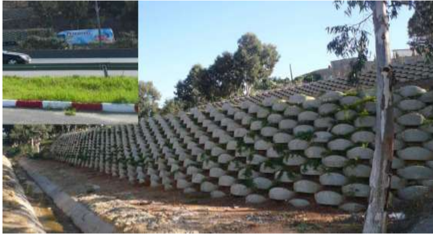
Figure I.11 : Photo d'un mur de soutènement de terre armée avec écaille en béton.
