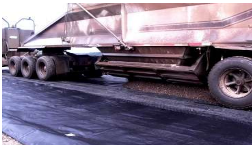
Figure II.24: Mise en place des géosynthétiques dans une construction de route.
