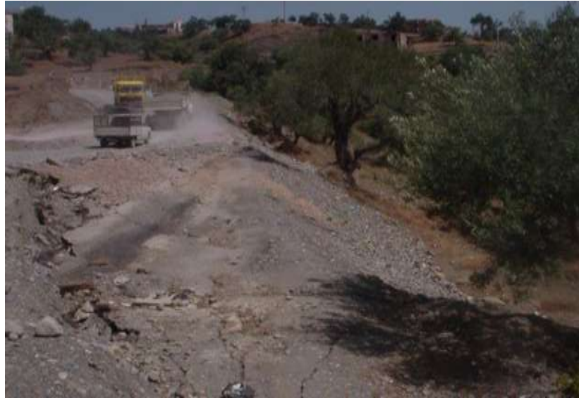
Figure I.24 : Un important glissement de terrain qui gêne la circulation sur la RN 26 A (Bejaïa)
