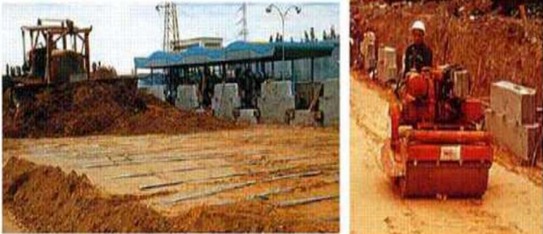
Figure I.16 : Remblaiement et le compactage d'une couche de sol.
