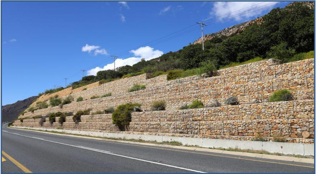
**Figure IX.06:** Exemple de mis en place le mur de soutènement en gabion coté déblai. [21]
