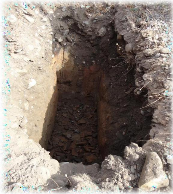
Puits 1 PK 1+020 la marne surmonté par une couche de remblai. [11]
