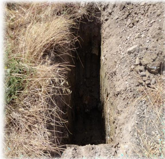
: Puits 3 PK 7+500 (*Argile marneuse surmonté d'une couche de remblai.*). [11]
