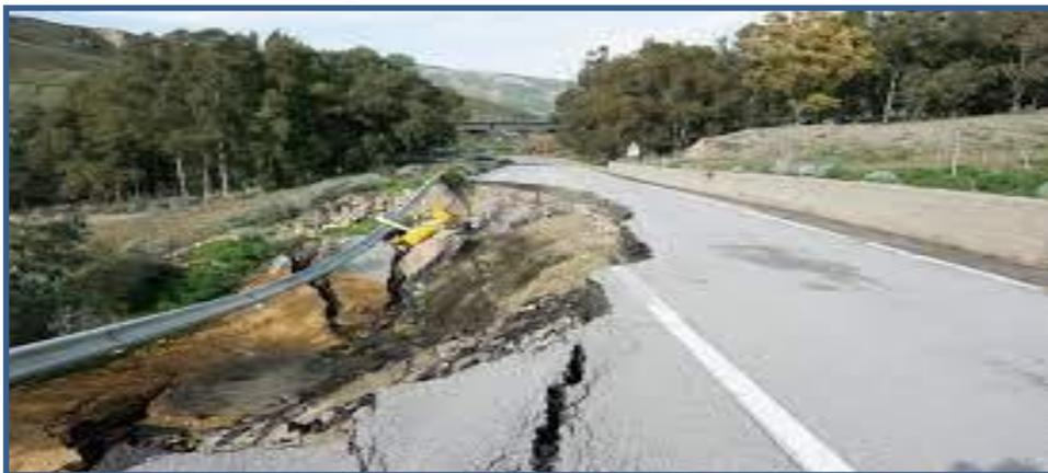
**Figure IX.04:** Quelques exemples des glissements terrain. [20]
