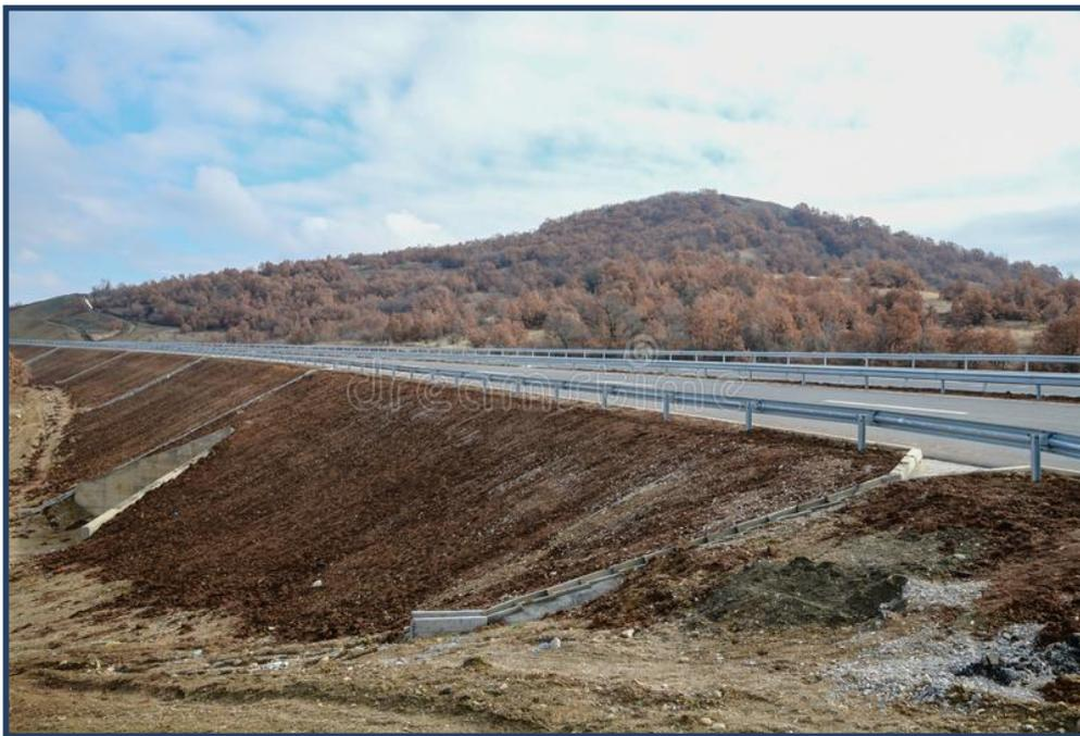
**Figure IX.02:** Traitement des talus types remblais. [18]
