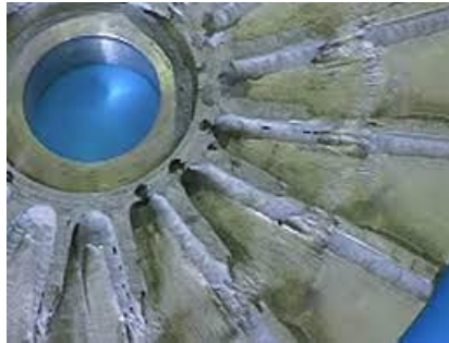
Fig. II 11 : Aspect de la corrosion caverneuse
