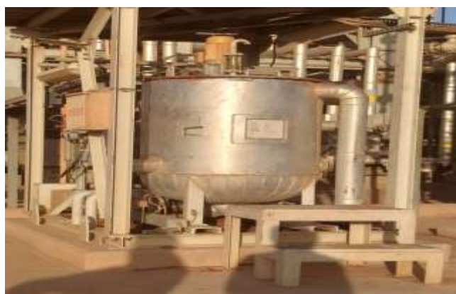
Figure.III.12 : Unité d'injection anti-mousse
