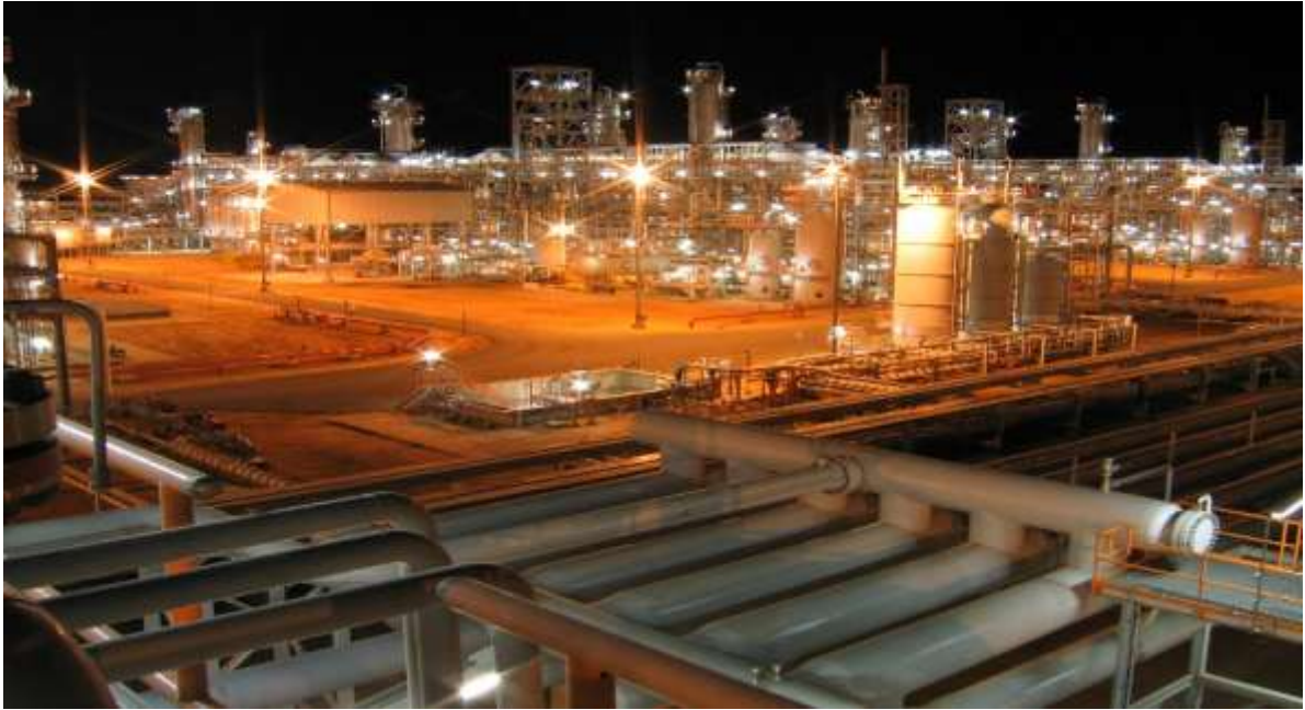
Figure I.4. Complexe de traitement Tiguentourine
