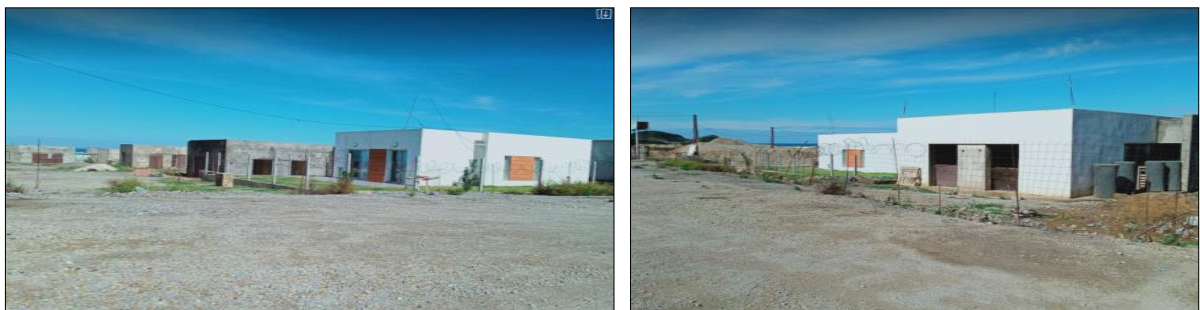
Figure III-24 : prise sur l'aire d'intervention
