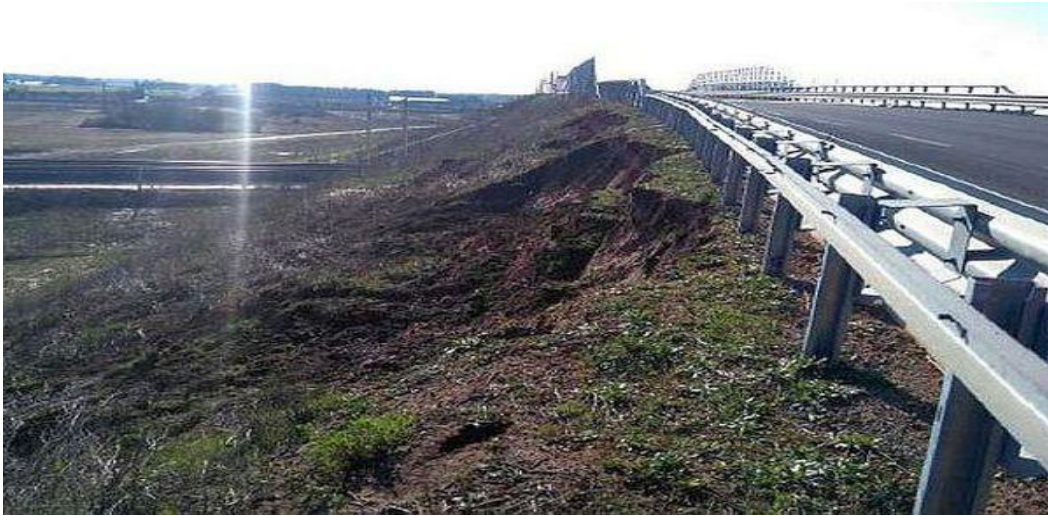
Fig.19. Glissement de talus produit sous la RD26 qui enjambe la nouvelle LGV France
