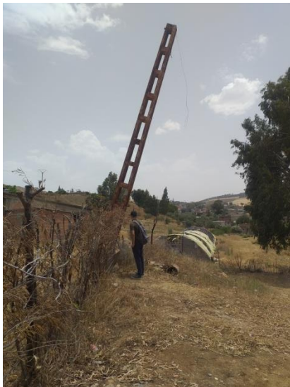
Photos VI.2. L'inclinaison des poteaux électricité et maison menacée par le glissement de terrain.
