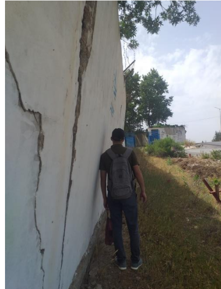
Photos VI.1. Des fissurations et rupture de sol et sur les constructions.
