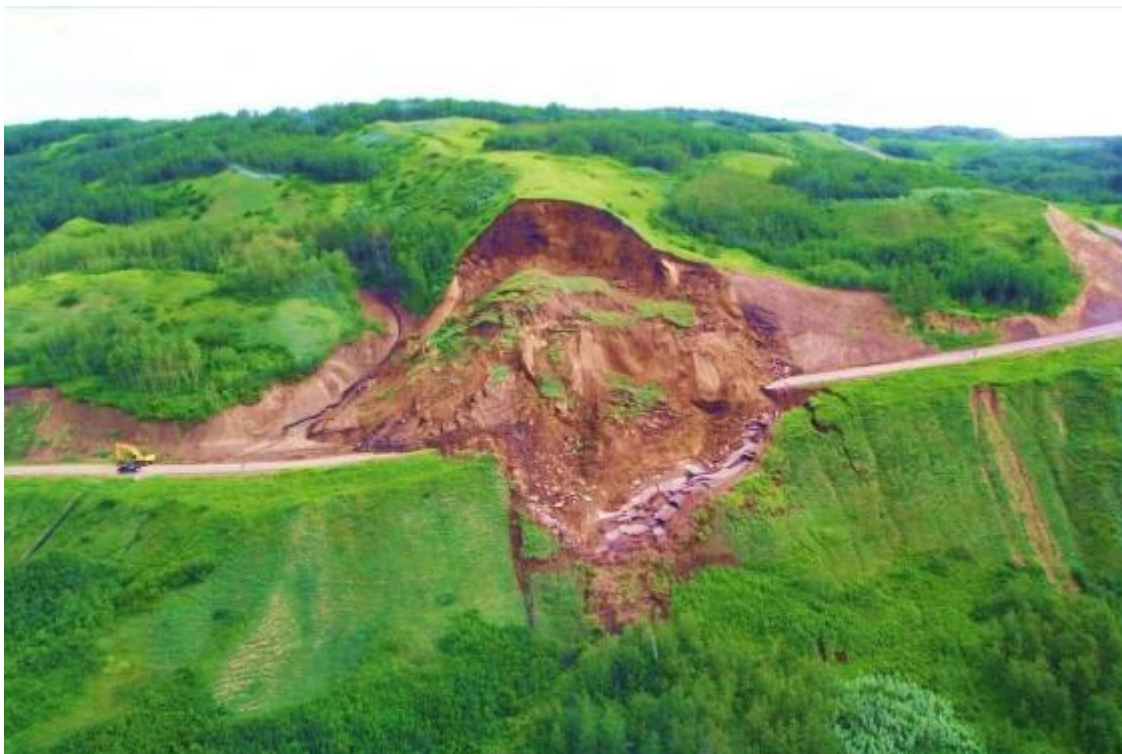
Fig.IV.1. Glissement de terrains.
